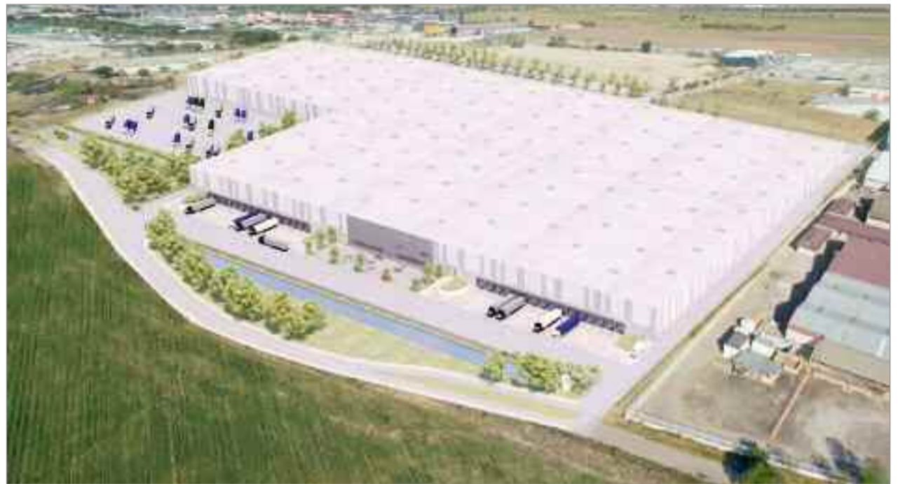
Ubicado en el polígono industrial 'El Encín', en el Corredor del Henares, este nuevo centro logístico – el segundo en la Comunidad de Madrid – estará operativo a principios de este otoño
